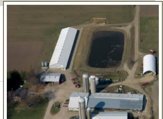
Les installations de stockage de fumier et d'autres matières biologiques sont la principale source des odeurs qui proviennent en permanence des fermes. Recouvrir les installations, ériger des clôtures pleines, planter des brise-vent et prendre d'autres mesures peut empêcher les odeurs de se rendre jusqu'aux propriétés avoisinantes.
