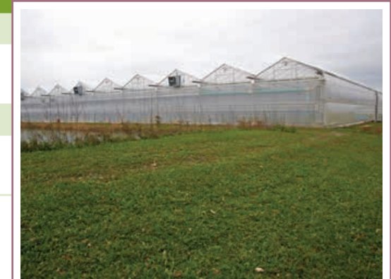
Si vous construisez une serre en plastique, efforcez-vous de la rendre la plus écoénergétique possible.
