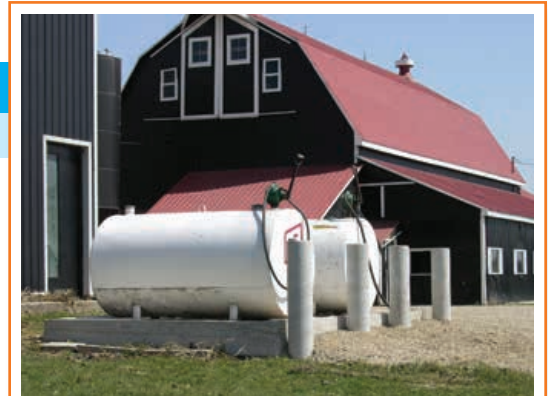
Une base solide aide à garder la zone du réservoir de stockage de combustible exempte de végétation.
