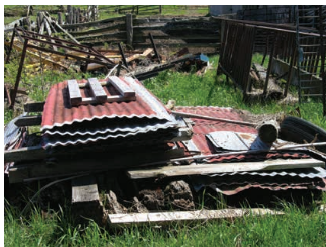
La plupart des composantes de bâtiments non contaminées peuvent être recyclées ou réutilisées.
