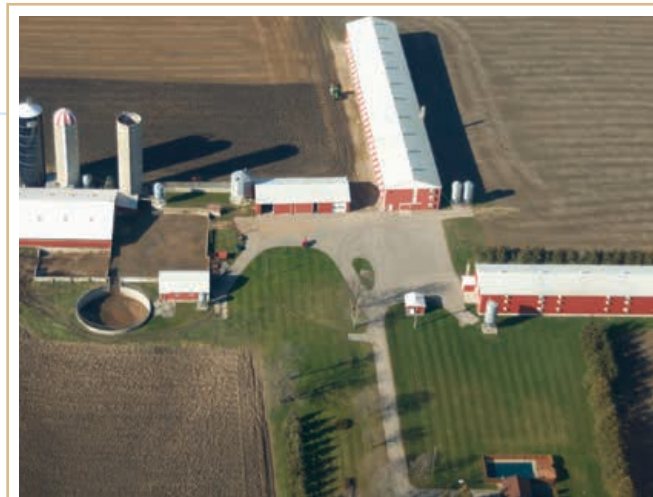
Toutes les eaux s'écoulant de cette cour entourée d'un mur sont recueillies dans un réservoir de stockage des liquides.
