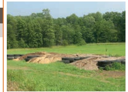
La voie d'écoulement séparant le site de compostage et l'eau de surface ou l'entrée des drains doit mesurer plus de 75 m (250 pi).
